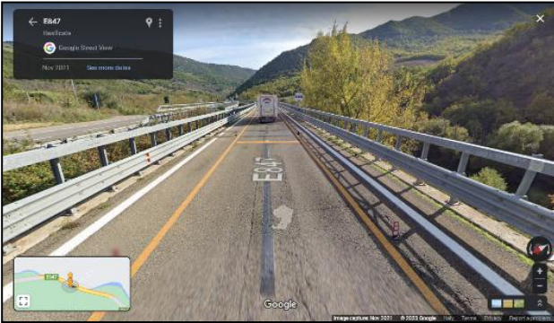
Sito Monitorato Viadotto MONTICELLO Albano di Lucania, Basilicata
