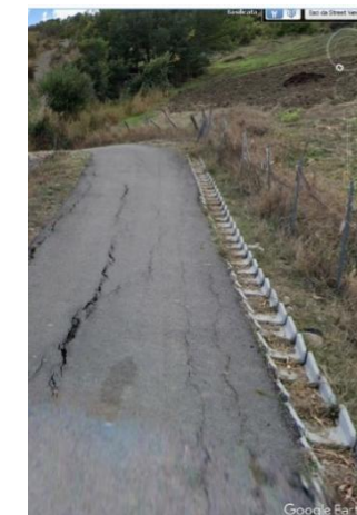
Chiare evidenze di deformazioni al suolo per presenza di frane attive
