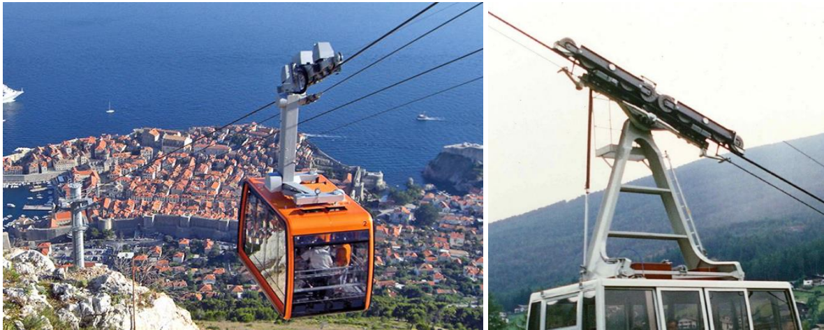
Figura 3: Funivia bifune a vai e vieni e relativi carrello e sospensione tipo
