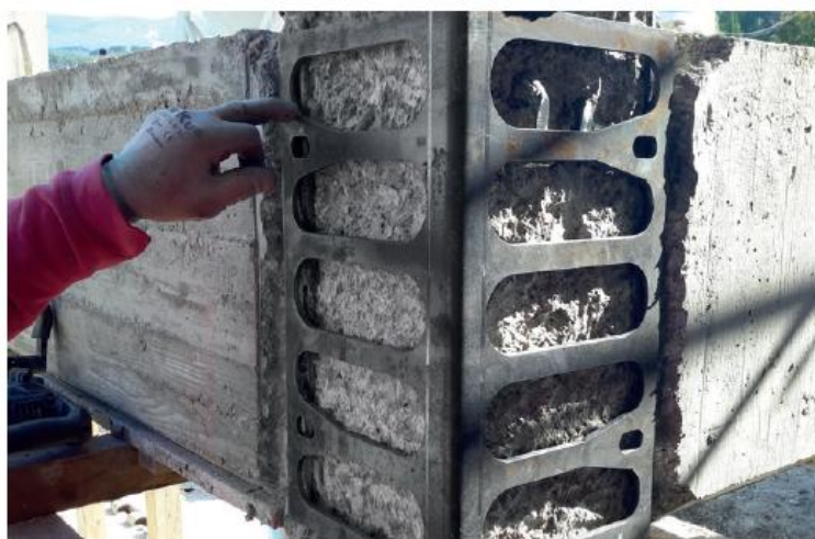
Figura 21. Esempio di applicazione della piastra SIS.MI.C.A. su un nodo d'angolo. Fonte [products.kerakoll.com].
