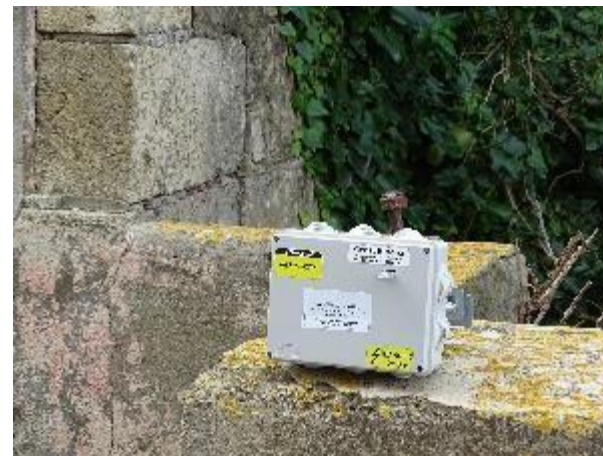
Stazione multisensore e multiparametrica lungo il fronte del dissesto analizzato nel versante nord-orientale dell'abitato.
