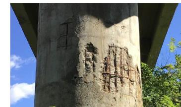
Valutazione dello stato di degrado delle pile delle opere della rete sulla base delle più recenti schede di ispezione
