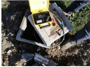
Monitoraggio della pressione interstiziale tramite piezometri elettrici
