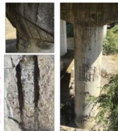
Degrado per corrosione delle barre di armatura di una pila di un'opera della SS407
